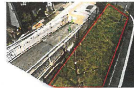
工事箇所(北棟)
